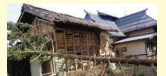
3月16日震度6の地震で家が倒壊
