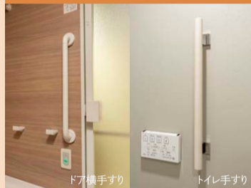
ドア横手すり
